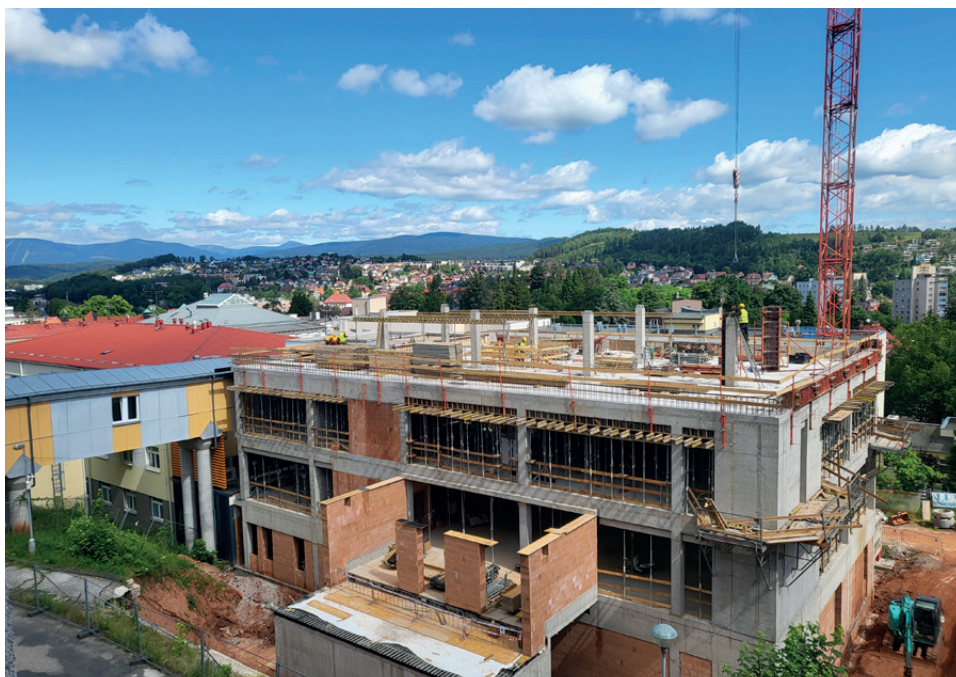
Stavba laboratoří - současný stav
